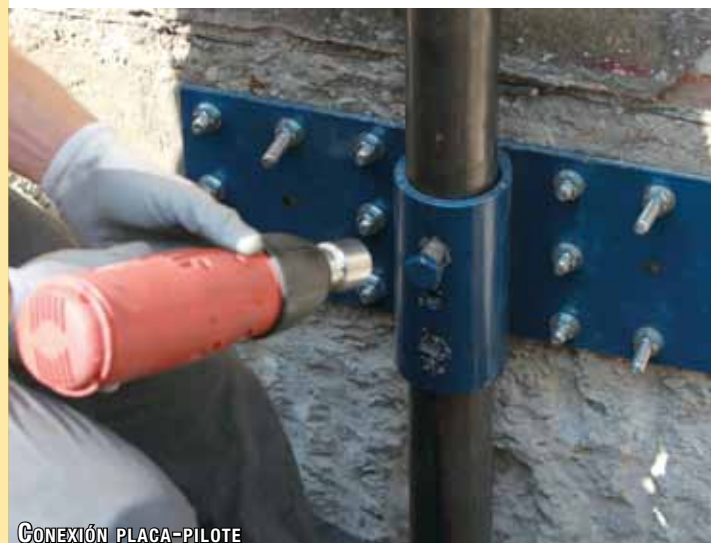
CONEXIÓN PLACA-PILOTE
