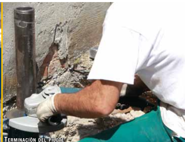
TERMINACIÓN DEL PILOTE
