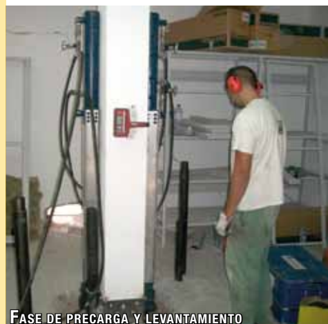
FASE DE PRECARGA Y LEVANTAMIENTO
