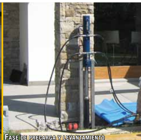
FASE DE PRECARGA Y LEVANTAMIENTO
