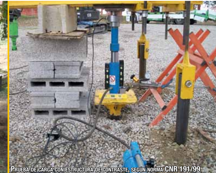
PRUEBA DE CARGA CON ESTRUCTURA DE CONTRASTE, SEGÚN NORMA CNR 191/99
