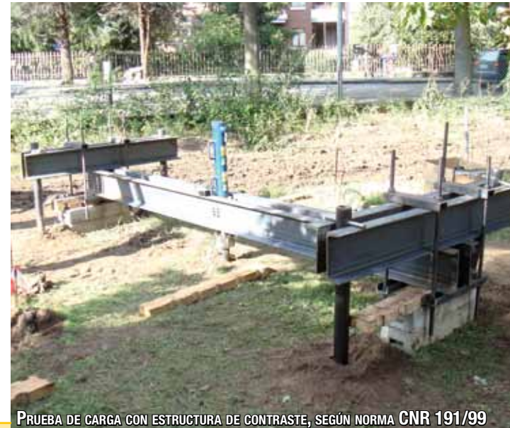
PRUEBA DE CARGA CON ESTRUCTURA DE CONTRASTE, SEGÚN NORMA CNR 191/99
