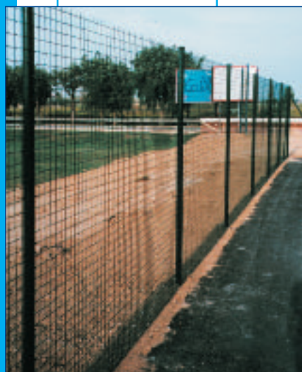
Cercado de malla, E.S.T., etc.
