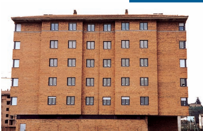
Edificio de viviendas Logroño (La Rioja)
