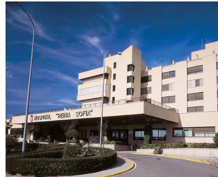
HOSPITAL COMARCAL REINA SOFÍA Arquitecto: Maruja Pérez Sérif Lugar: Tudela (Navarra) Material: Ladrillo Blanco Tudela
