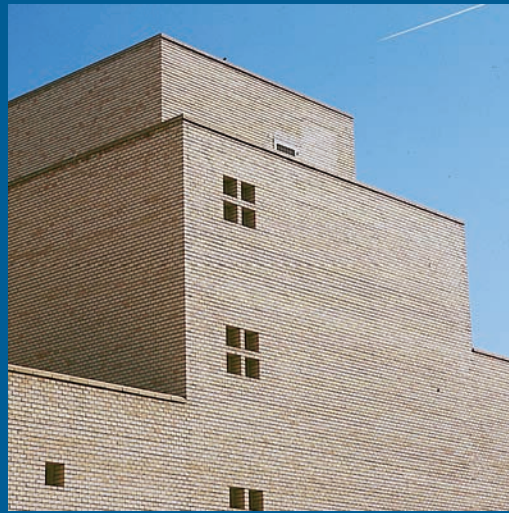
REAL CASA DE MISERICORDIA Arquitecto: Rafael Moneo Lugar: Tudela (Navarra)
