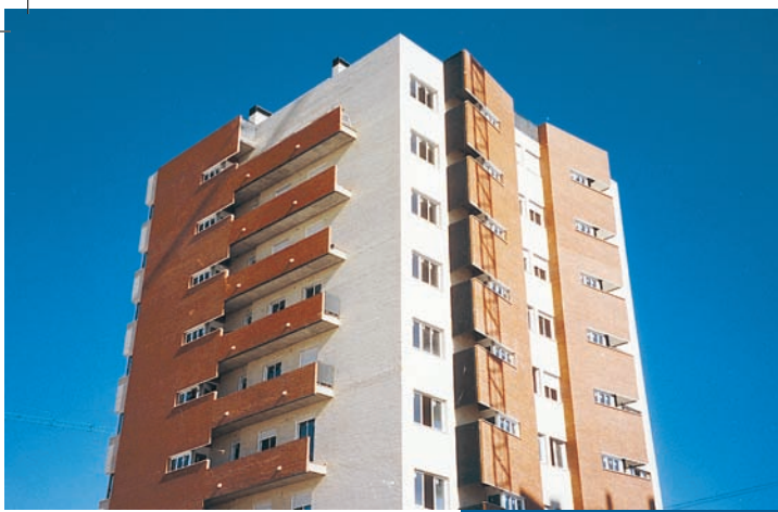
Edificio de viviendas (Madrid)
