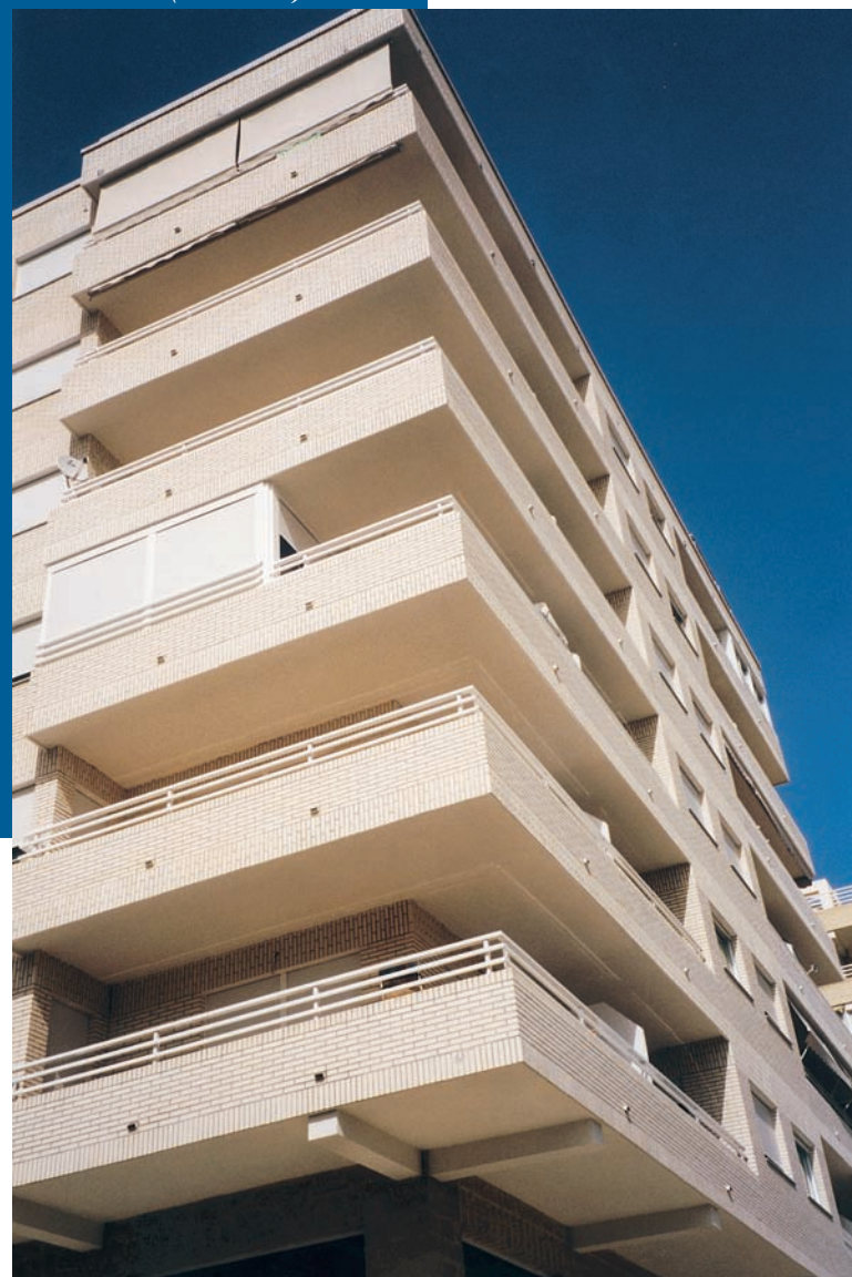
Edificio de apartamentos Benicarló (Castellón)
