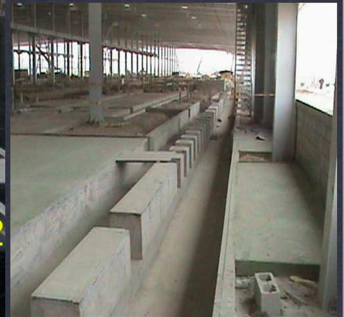
**PARA ESTOS TRABAJOS SE NECESITARON 2 TOPÓGRAFOS DE PLANTA, TRAZANDO Y DANDO PUNTOS YA QUE LAS BASES DE LOS EQUIPOS LLEVAN EMBEBIDOS DE ACERO Y DIFERENCIAS DE NIVELES**
