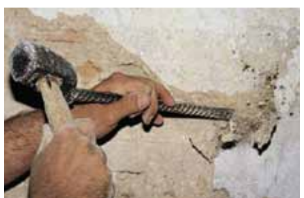
Humedad por remonte capilar
