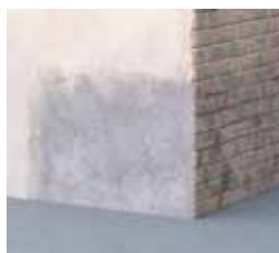
Humedad por remonte capilar
