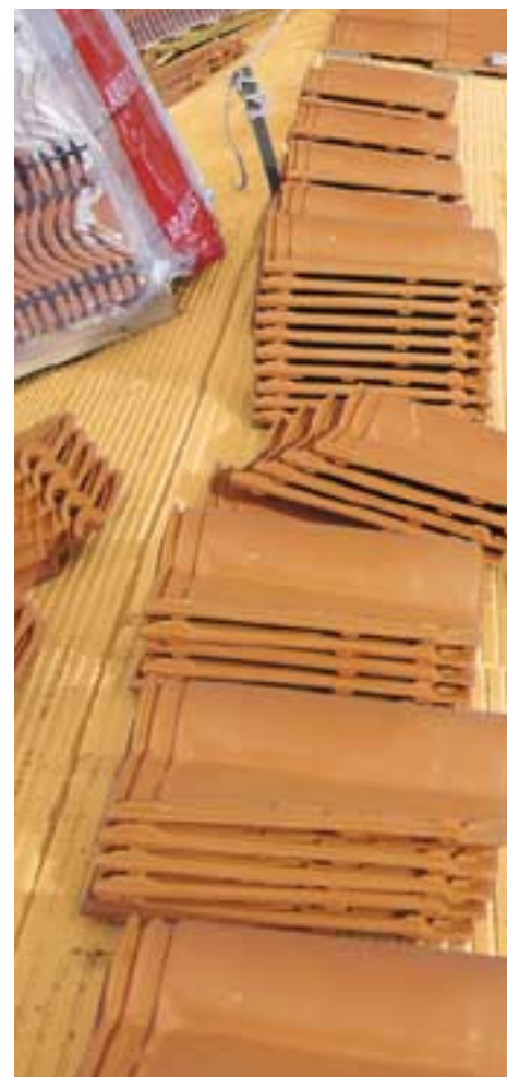
Canaboard. Instalación teja cerámica
