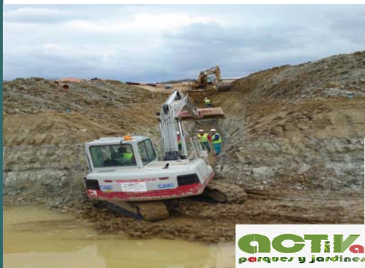
COLOCACIÓN DE ESCOLLERAS
