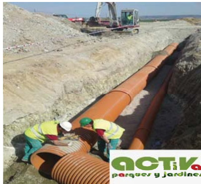
CANALIZACIONES PARA ILUMINACION Y ELECTRICAS
