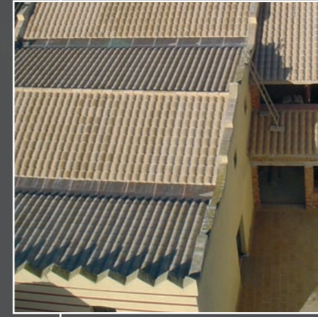
RESTAURACIÓ PATRIMONI HISTÒRIC
