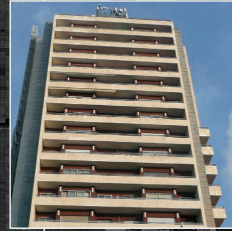
INTERVENCIONS EN ESTRUCTURES
