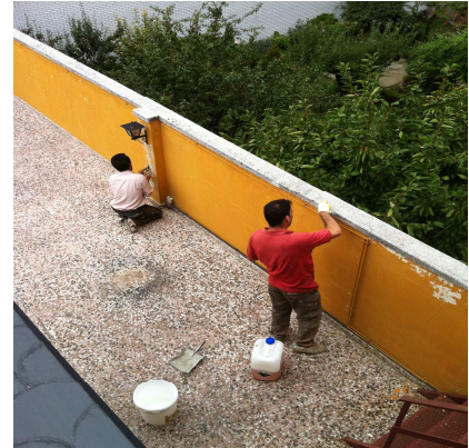
Limpieza y sellado de muros
