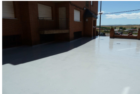
Superficie terminada con membrana de Poliuretano Plus 250
