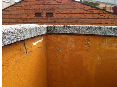
Soporte inicial del muro
