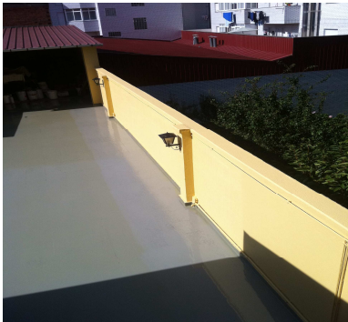
Acabado final del muro y 1º mano de Poliuretano Plus 250
