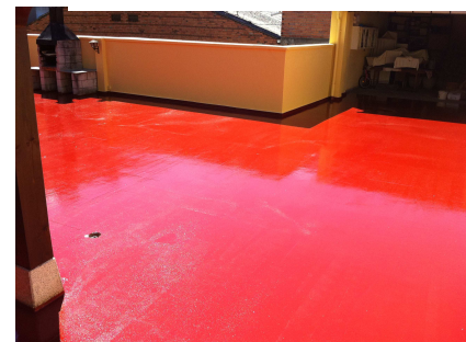
Acabado final Poliuretano plus 400 Color + microsferas
