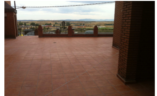
Terraza terminada con gres
