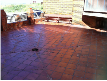
Imagen con el soporte inicial de la terraza
