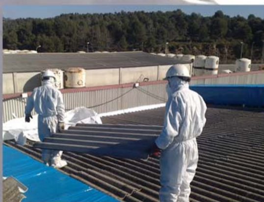
λ Retirada de placas de fibrocemento
