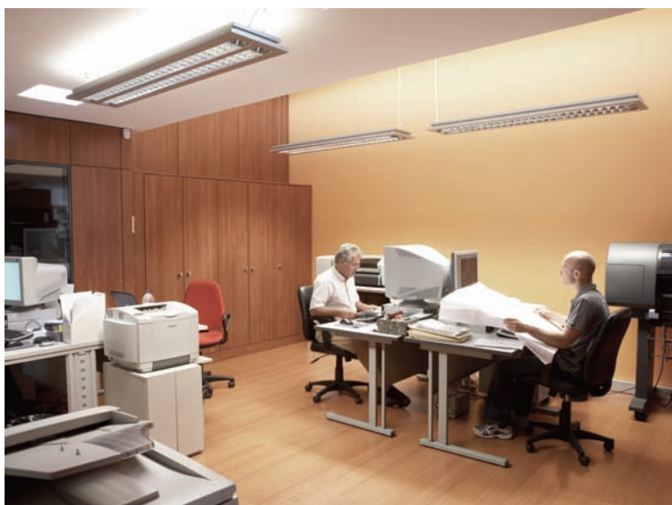
Luminaria con óptica de sección parabólica con alto confort visual
