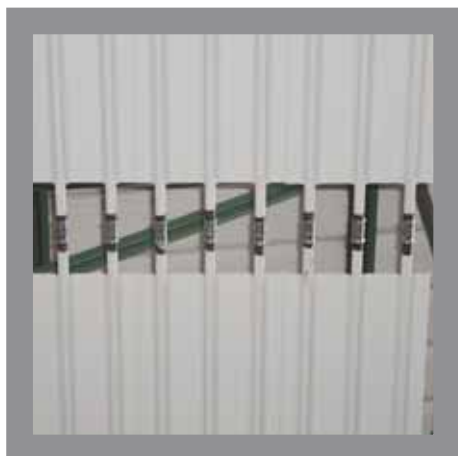
Arriba: Unión tipo pressfitting. Abajo: Embellecedor para las uniones.
