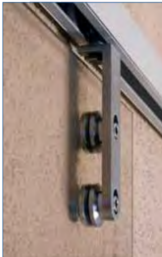
Fijación directa al techo sin encaste en vidrio
