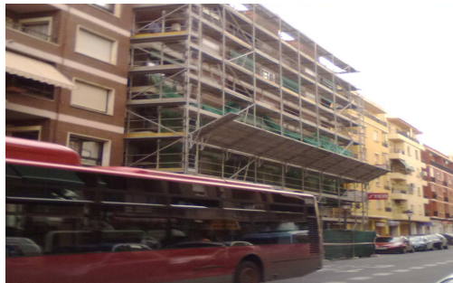
Rehabilitación de fachada en valencia
