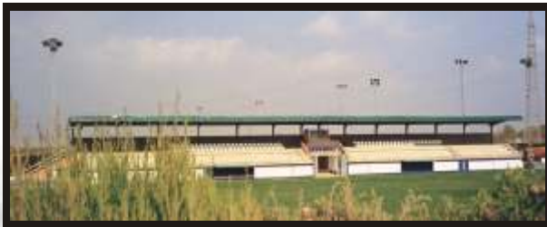
Trabajos especiales Polideportivo El Chopo (Ayto. de Galapagar)
