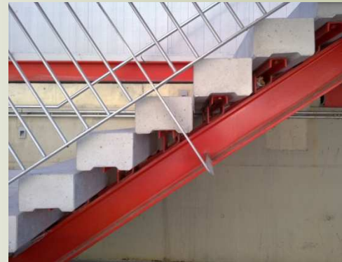
PELDAÑOS ESPECIALES EN HORMIGÓN
