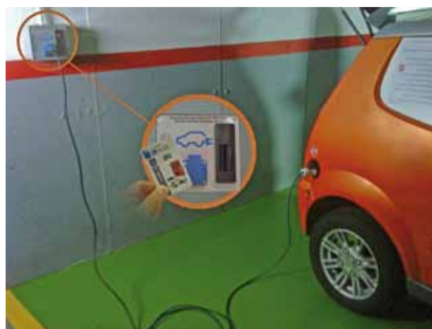
Ejemplo recarga en aparcamiento
