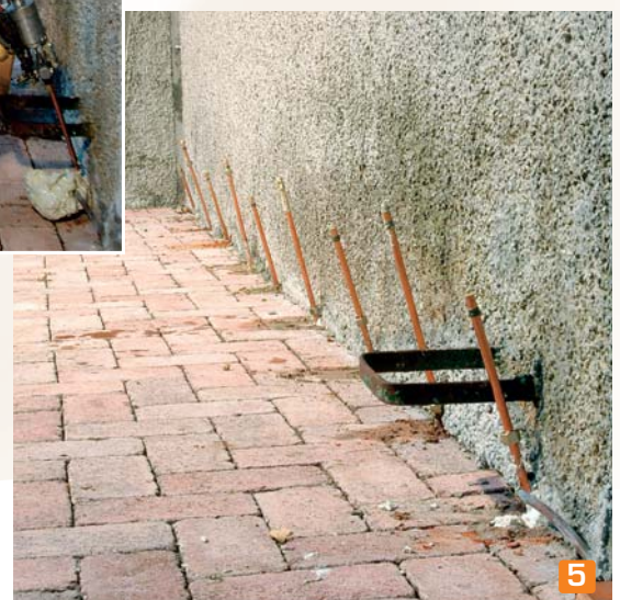
LOS TUBOS SON SECCIONADOS A NIVEL DEL SUELO O DE LA SOLERA
