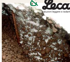
Relleno completo y puesta en tensión de cavidades subterráneas.
