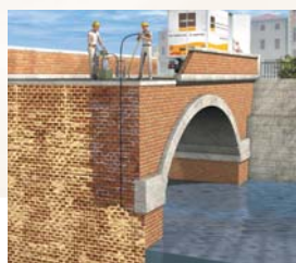
Inyecciones para la consolidación de mampostería deteriorada.
