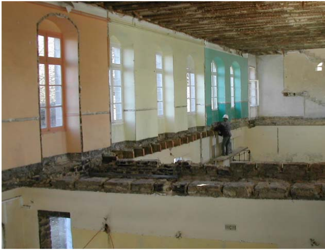
Vista del edificio tras la retirada de los suelos de madera.
