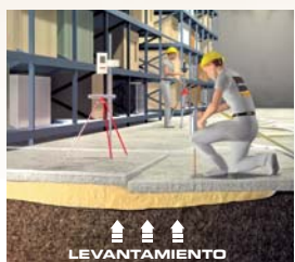
Levantamiento de pavimentos con inyecciones de resina expansiva.
