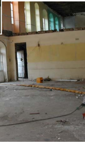
Inyección bajo los muros en mampostería.
