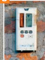
INYECCIÓN DE LA RESINA Y LEVANTAMIENTO CONTROLADO POR EL NIVEL LÁSER
