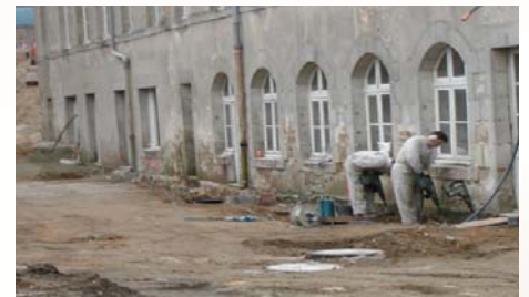
Inyección bajo los muros en mampostería.
