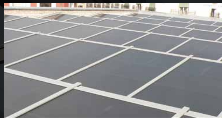
Fig. Lucernario fotovoltaico en Madrid, construido con doble acristalamiento fotovoltaico Arquitectos: García + Montiel (QVE Arquitectos) Potencia Pico: 6.430 W
