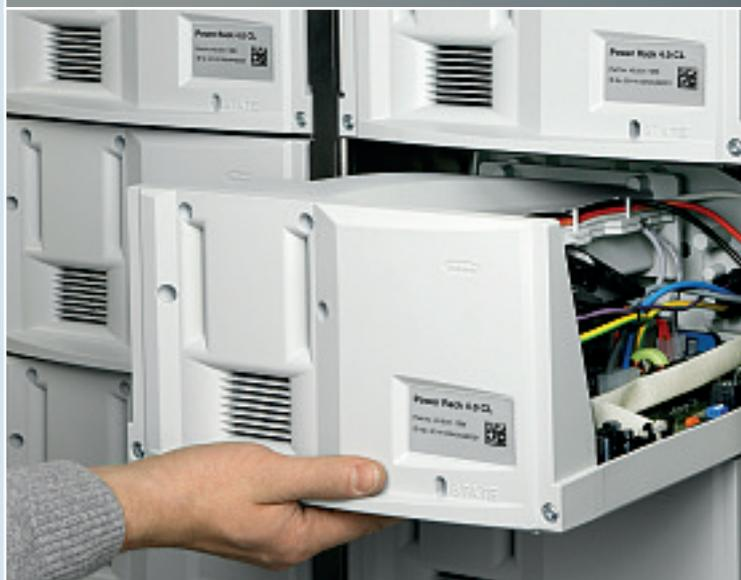
Las hasta 15 partes de potencia idénticas del Fronius CL generan un sistema redundante. Se trata de un concepto muy sofisticado para garantizar la máxima seguridad contra averías.
