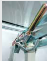
Activación térmica para apertura automática
