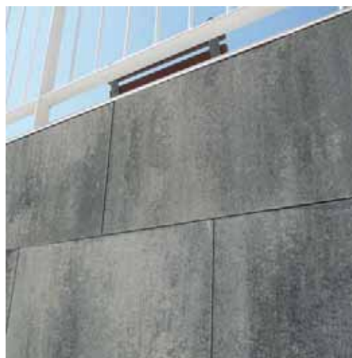
Viviendas en Teià. Barcelona. Llosa Vulcano aplacada. Ref. Ceniza Homes in Teià. Barcelona. Stone cladding Llosa Vulcano. Ref. Ceniza
