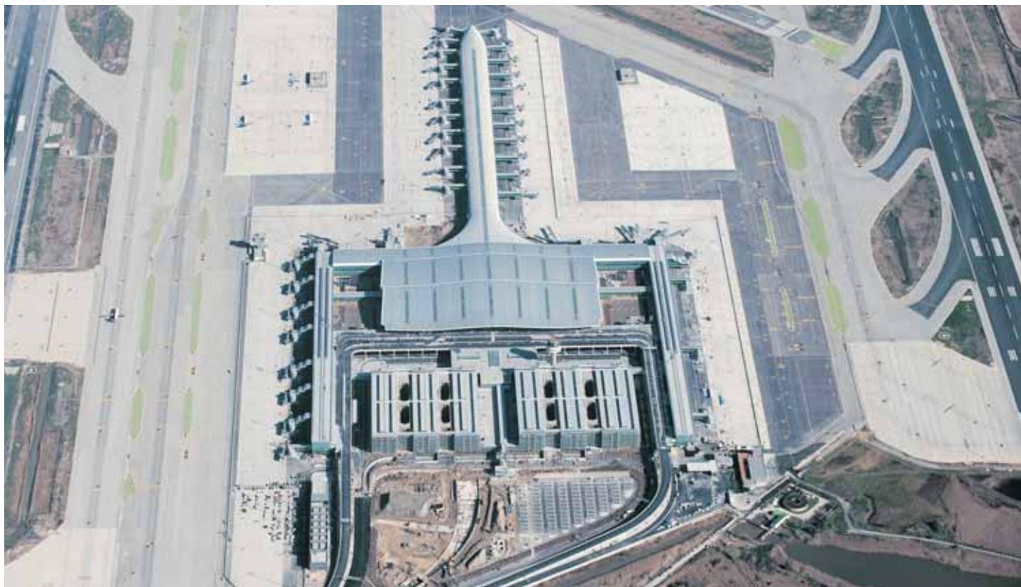
Terminal Sur Aeropuerto de Barcelona. Promotor: Aena. Proyecto: R. Bofill
