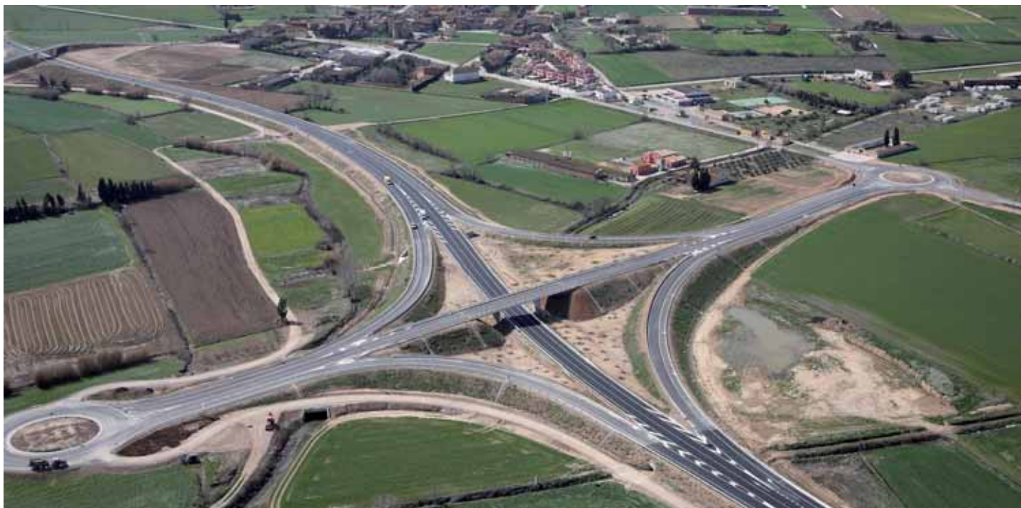
Carretera C-31. Tramo: La Tallada d'Empordà-Torroella de Fluvià. Promotor: Gisa. Proyecto: Félix Campo Chavarrí, Carlos Hernando Martínez - Auding
