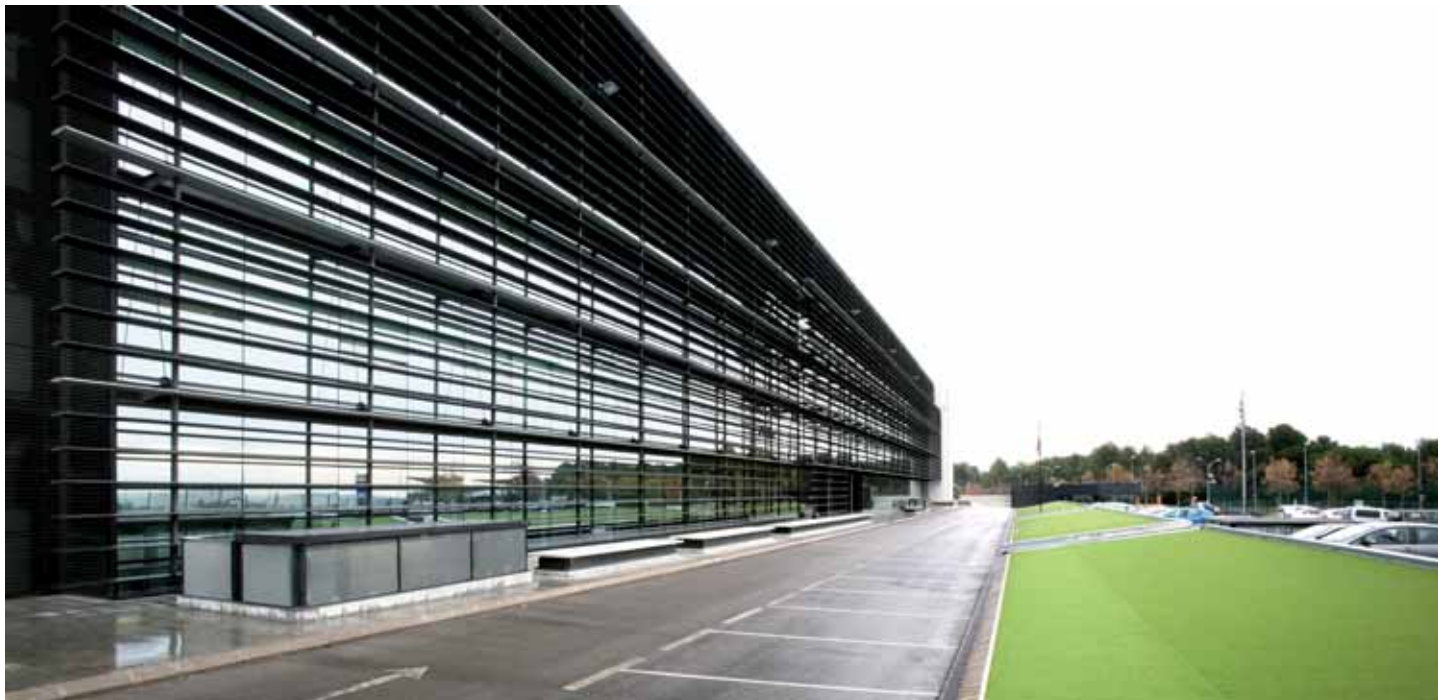
Complejo Central Mossos d'Esquadra, Sabadell. Promotor: Gisa. Proyecto: B23 Arquitectura SCP
