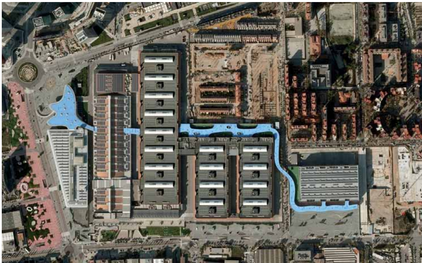
Ampliación Fira de Barcelona en Gran Via. Promotor: Fira 2000 SA. Proyecto: Toyo Ito & Associates Architects
