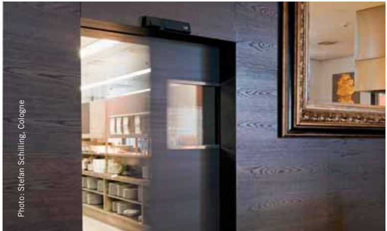
El operador para puertas automáticas correderas ES 200 asegura un máximo de eficiencia de movimientos de la cocina (izquierda) al restaurante (derecha).
