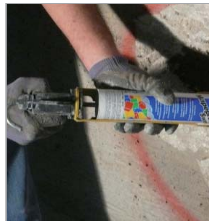
Fig. 8.3 - Estrusione di MAPEPROOF SWELL su di una zona interessata da una venuta d'acqua preventivamente bloccata mediante LAMPOSILEX
