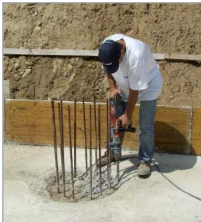
Fig. 7.15 - Scapitozzatura della testa del palo
