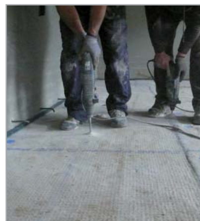
Fig. 8.6c - A seguito della posa di MAPEPROOF sul magrone, si realizzano i fori per l'inserimento dei connettori metallici
