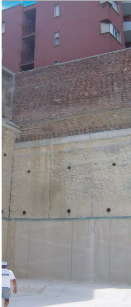
Fig. 4.2 - Scavo di sbancamento confinato mediante diaframmi
