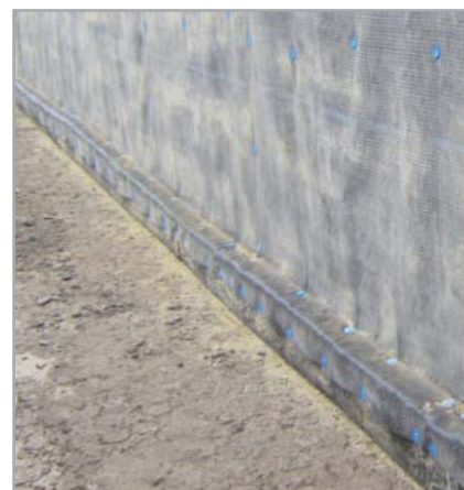
Fig. 7.45b - Parete verticale impermeabilizzata con MAPEPROOF in post-getto
