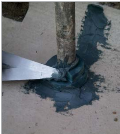
Fig. 7.60e - Ulteriore stuccatura mediante MAPEPROOF MASTIC
