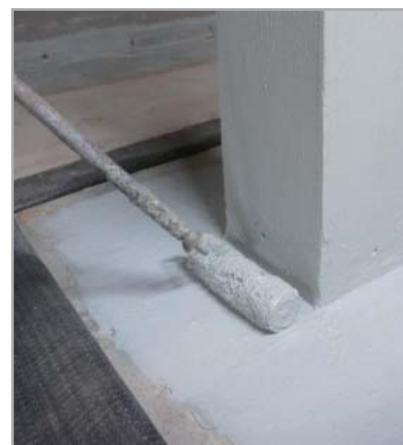
Fig. 8.6b - Applicazione di MAPELASTIC FOUNDATION anche sui pilastri
