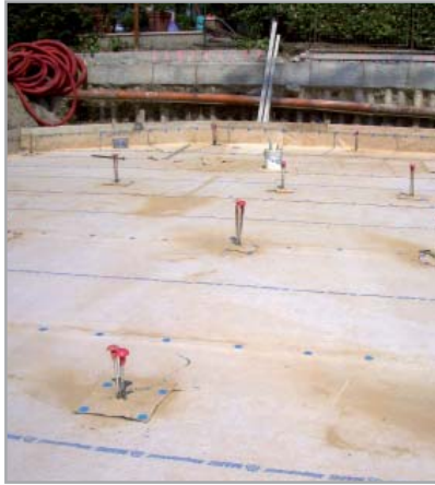
Fig. 7.27 - Visione d'insieme dell'impermeabilizzazione di una serie di teste di pali
