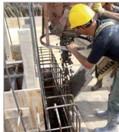
Fig. 7.5f - Getto delle pareti verticali
