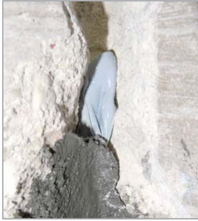
Fig. 8.1d - Confinamento di MAPEPROOF SWELL mediante applicazione di MAPEGROUT T40
