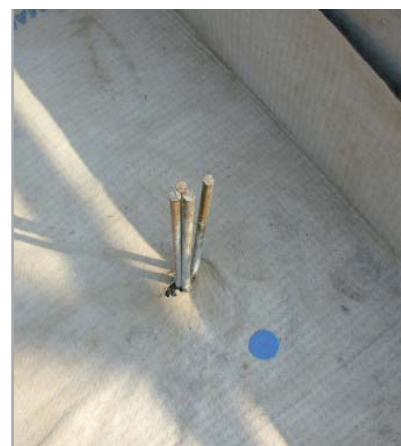
Fig. 7.24 - MAPEPROOF attraversato dalle armature del palo
