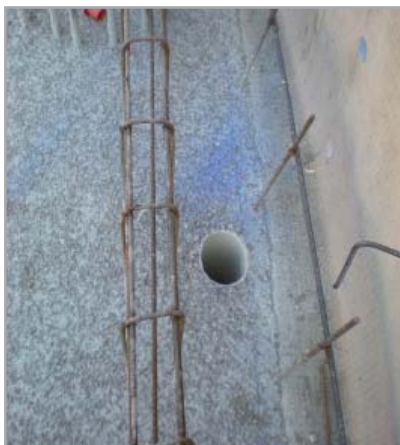
Fig. 7.75 - Foro lasciato nella soletta per consentire l'esecuzione dei getti delle pareti verticali
