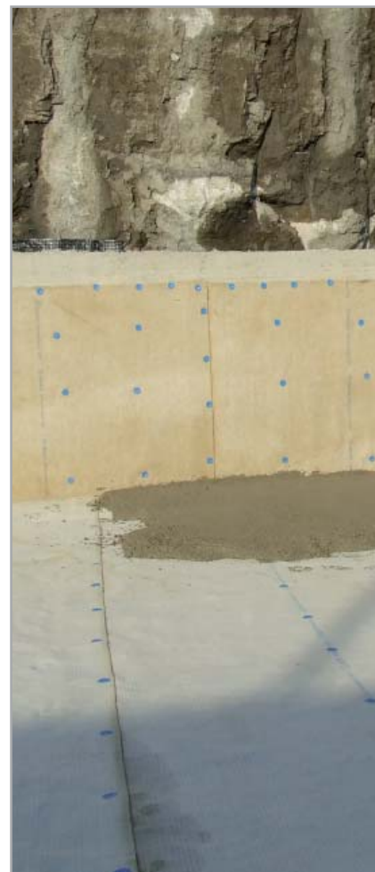
Fig. 7.9 - Fasi di getto, al di sopra di MAPEPROOF, della cappa di protezione realizzata con calcestruzzo di pari Rck di quello di platea
