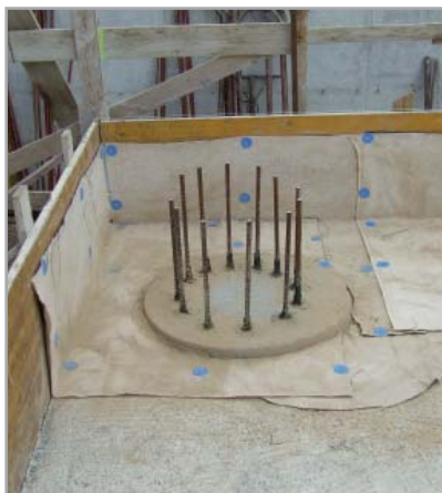
Fig. 7.20 - MAPEPROOF sagomato intorno alla testa del palo
