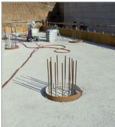
Fig. 7.16 - Cassero cilindrico metallico posizionato per l'esecuzione del getto con MAPEGROUT COLABILE
