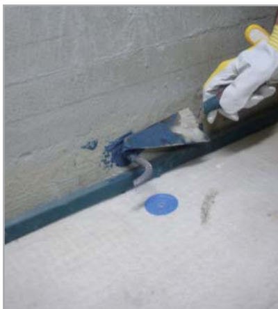
Fig. 8.6f - Stuccatura dei connettori metallici mediante MAPEPROOF MASTIC
