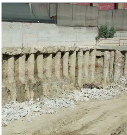
Fig. 4.3 - Scavo di sbancamento confinato mediante pali trivellati
