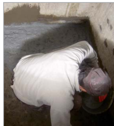
Fig. 8.8a - Fasi di realizzazione di un rivestimento impermeabile con malta idrofugata a base di IDROSILEX sul piano orizzontale e MAPELASTIC FOUNDATION sulle superfici verticali e sul piano orizzontale: stesura di una boiaccia di adesione
