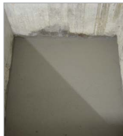
Fig. 8.8b - Massetto composto di sabbia-cemento e IDROSILEX
