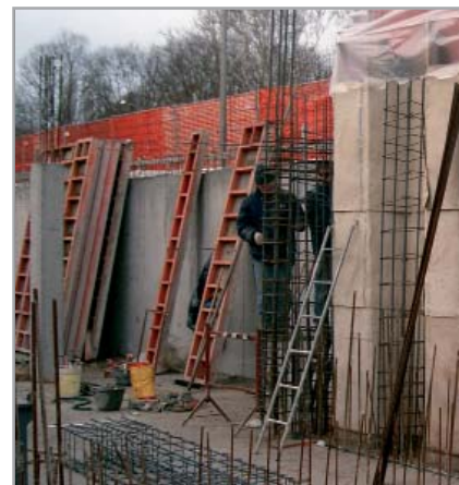
Fig. 7.31 - Applicazione di MAPEPROOF direttamente sulle palancole
