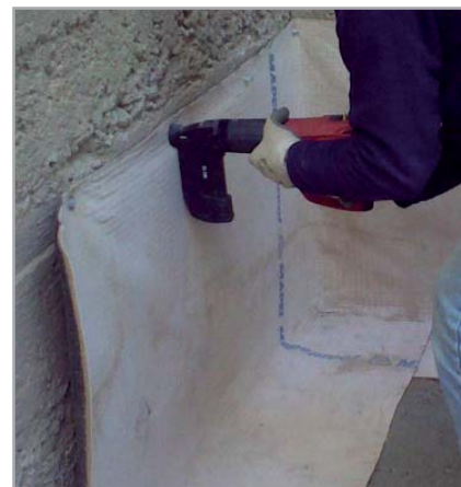
Fig. 8.5a - Fasi di realizzazione di una rifodera interna realizzata con MAPEPROOF su orizzontale e verticale: applicazione MAPEPROOF sulla parte bassa delle pareti verticali risvoltando il telo sul magrone
