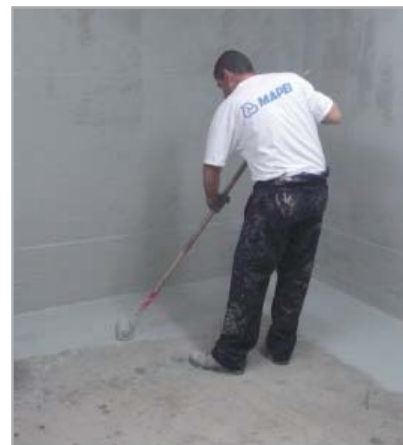
Fig. 8.6a - Fasi di realizzazione di una rifodera interna realizzata con MAPELASTIC FOUNDATION sulle pareti verticali e MAPEPROOF sull'orizzontale: applicazione di MAPELASTIC FOUNDATION sulle pareti verticali e sul nuovo magrone di pulizia per una fascia di 50 cm almeno
