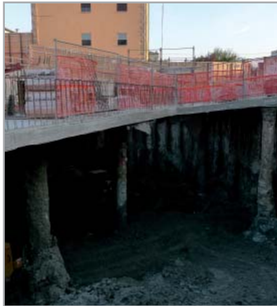
Fig. 7.73 - Scavo eseguito al di sotto della soletta gettata precedentemente
