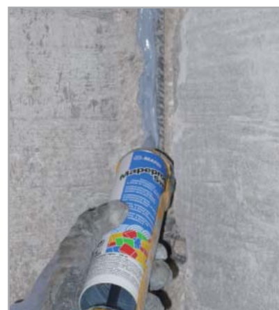
Fig. 8.1b - Estrusione di MAPEPROOF SWELL
