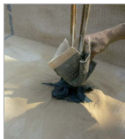
Fig. 7.25 - Rinforzo localizzato dell'impermeabilizzazione mediante uno spezzone di MAPEPROOF e stuccatura con MAPEPROOF MASTIC
