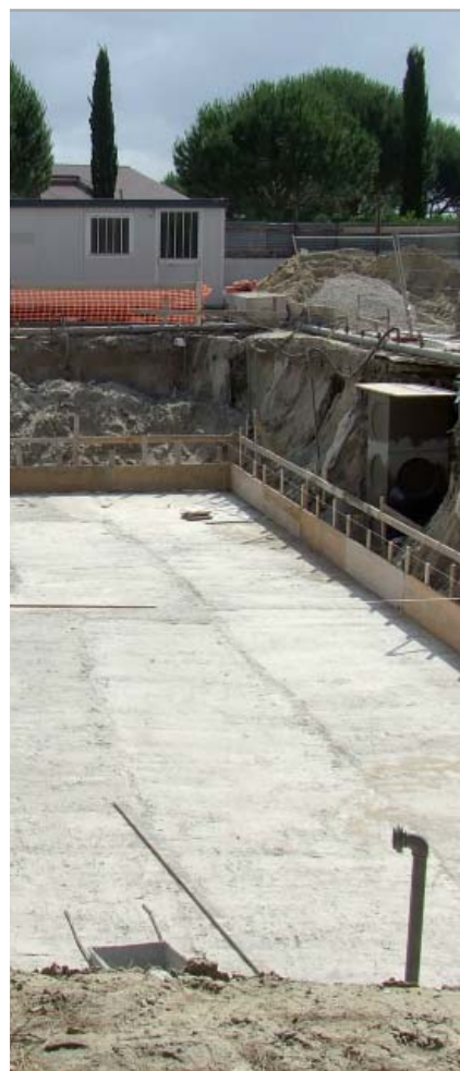
Fig. 4.1 - Scavo di sbancamento non confinato
