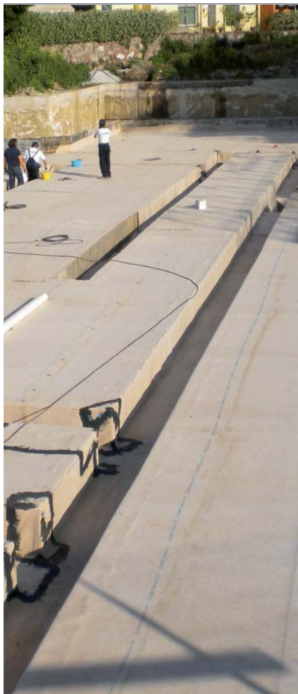
Fig. 7.12 - Stesura di MAPEPROOF mediante l'impiego di un bilanciino metallico
