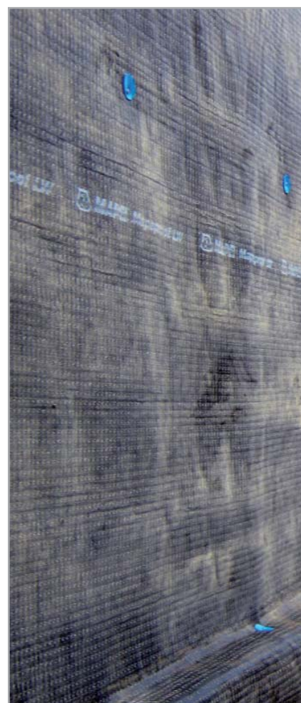
Fig. 5.3 - Esempio di applicazione di MAPEPROOF in post-getto
