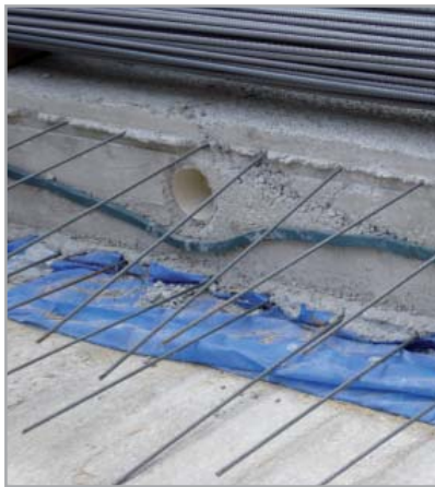
Fig. 7.29 - Sigillatura di una ripresa di getto in platea con IDROSTOP B25. E' visibile anche il foglio in PE posto a protezione della fascia di Mapeproof che fuoriesce dalla platea per garantire il sormonto con il telo che verrà posto prima del getto successivo
