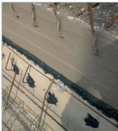
Fig. 7.71 - Sigillatura del raccordo tra MAPELASTIC FOUNDATION e MAPEPROOF utilizzando MAPEPROOF MASTIC e successiva chiodatura di IDROSTOP B25
