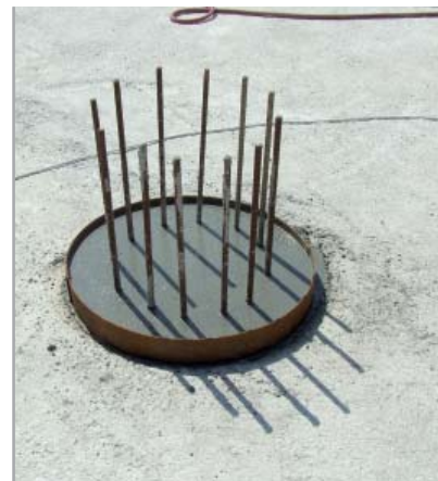
Fig. 7.17 - Testa del palo ricostruita con MAPEGROUT COLABILE
