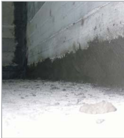
Fig. 8.1e - Riprese di getto sigillate e ripristinate
