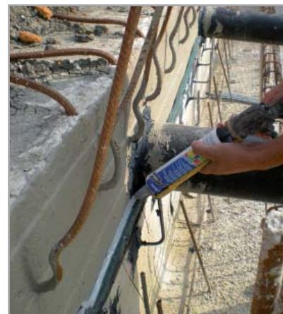
Fig. 7.72 - Estrusione di MAPEPROOF SWELL su IDROSTOP B25 nel raccordo tra MAPELASTIC FOUNDATION e MAPEPROOF
