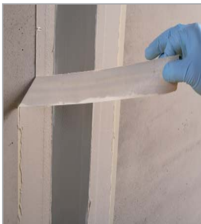
Fig. 7.48e - Prima della reticolazione di ADESILEX PG4 eseguire uno spolvero di quarzo a rifiuto e rimuovere il nastro di carta
