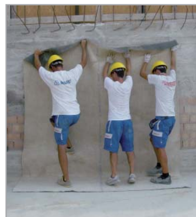
Fig. 7.68 - Telo bentonitico posato sulla superficie verticale e poi risvoltato su quella orizzontale
