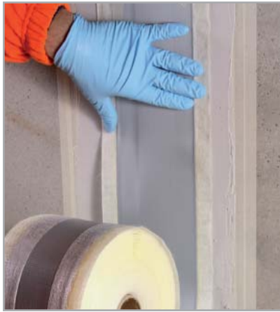
Fig. 7.48c - Posizionamento di MAPEBAND TPE
