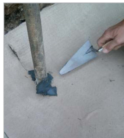
Fig. 7.60b - Applicazione di MAPEPROOF MASTIC al di sopra del telo
