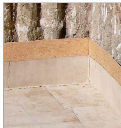
Fig. 7.33 - Applicazione di MAPEPROOF su pannelli OSB in appoggio ai pali
