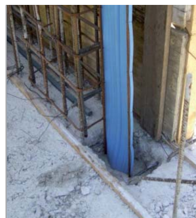
Fig. 7.56c - Posizionamento e fissaggio alle armature di IDROSTOP PVC BI
