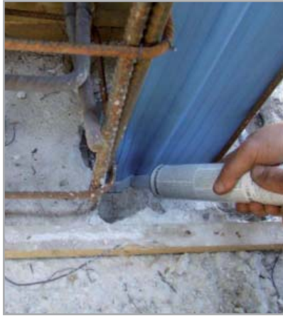
Fig. 7.56d - Sigillatura con MAPEPROOF SWELL
