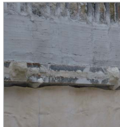
Fig. 7.36 - Paratia in micropali regolarizzata con MAPEGROUT T60
