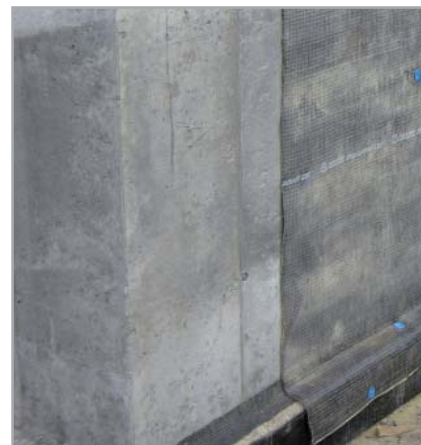
Fig. 7.45a - Chiodatura al supporto di MAPEPROOF in post-getto
