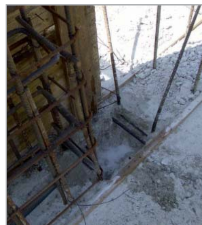
Fig. 7.56b - Demolizione per una profondità di circa 15 cm della parte superiore della platea
