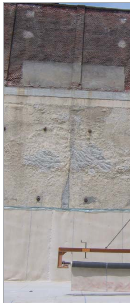
Fig. 7.37 - Posa di MAPEPROOF contro un diaframma
