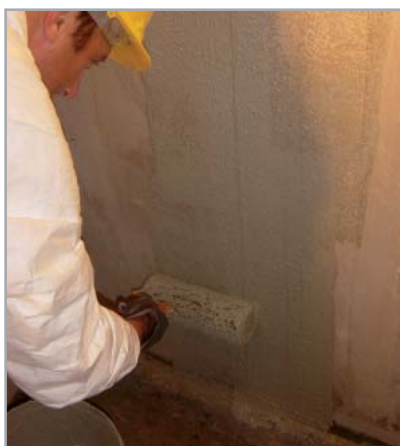
Fig. 8.8e - Applicazione di MAPELASTIC FOUNDATION
