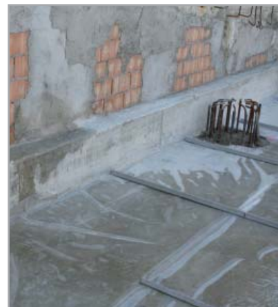
Fig. 7.66 - Applicazione di un foglio in PE per eseguire una soletta con intradosso regolare
