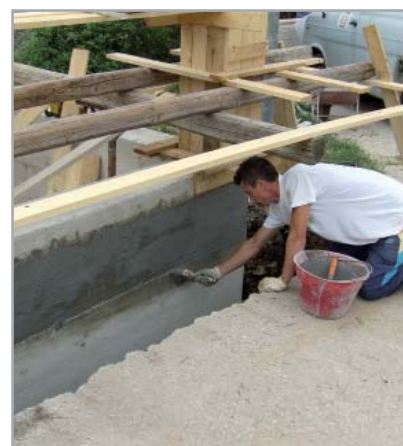
Fig. 7.47 - Applicazione a pennello di MAPELASTIC FOUNDATION sulla parte superiore della parete prima di applicare MAPEPROOF
