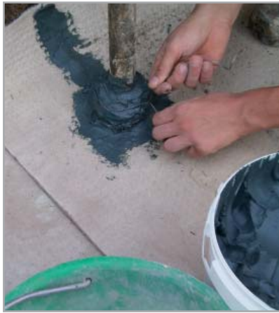
Fig. 7.60d - Fissaggio di IDROSTOP B25 mediante filo metallico
