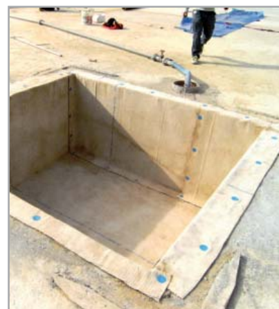
Fig. 7.5b - Fossa ascensore rivestita con MAPEPROOF
