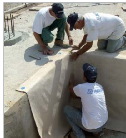
Fig. 7.5a - Fasi di impermeabilizzazione e getto di una fossa ascensore: applicazione di MAPEPROOF sulle pareti dello scavo
