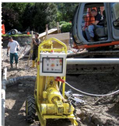
Fig. 3.6 - Operazioni di trivellazione per l'inserimento delle punte aspiranti
