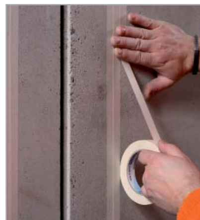
Fig. 7.48a - Fasi dell'impermeabilizzazione elastica di un giunto di dilatazione, soggetto a movimenti fino a 10 mm, con MAPEBAND TPE: per evitare sbavature laterali dell'adesivo epossidico, stendere del nastro di carta ai lati del giunto
