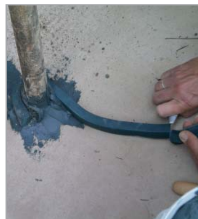
Fig. 7.60c - Posa di IDROSTOP B25
