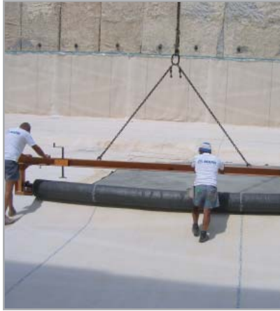
Fig. 7.12 - Stesura di MAPEPROOF mediante l'impiego di un bilanciino metallico
