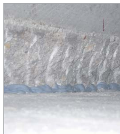
Fig. 8.1c - Ripresa di getto sigillata con MAPEPROOF SWELL
