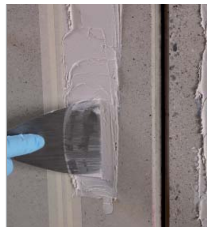
Fig. 7.48b - Stesura a spatola di ADESILEX PG4
