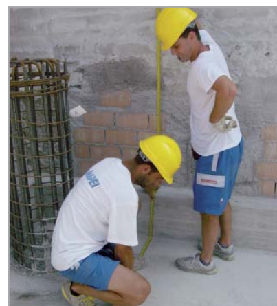
Fig. 7.67 - Misurazioni per definire le dimensioni per il taglio del telo MAPEPROOF, che dovrà partire da almeno 1 m dall'attuale fondo scavo
