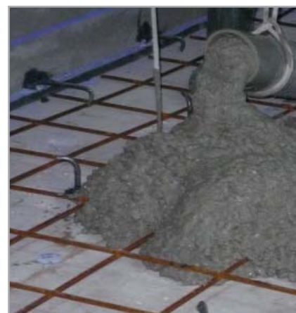
Fig. 8.6h - Esecuzione del getto della soletta in c.a. calcolata per contrastare la spinta dell'acqua di falda
