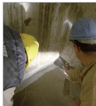
Fig. 8.8c - Applicazione di EPORIP nei raccordi tra piano orizzontale e superfici verticali e tra pareti contigue
