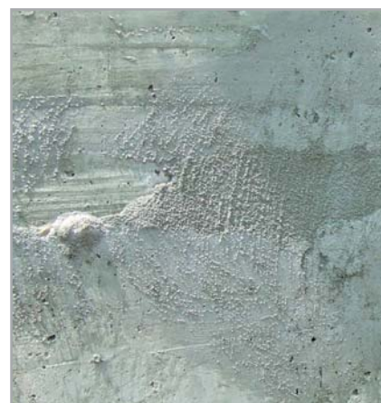
Fig. 7.44 - Regolarizzazione della superficie in calcestruzzo dopo la rimozione delle lame di cassero
