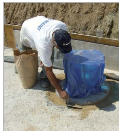
Fig. 7.19 - Sigillatura del perimetro della testa del palo con MAPEPROOF SEAL
