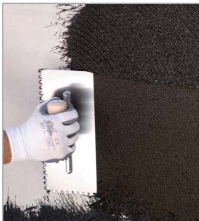
Fig. 7.54 - Applicazione di PLASTIMUL 2K SUPER
