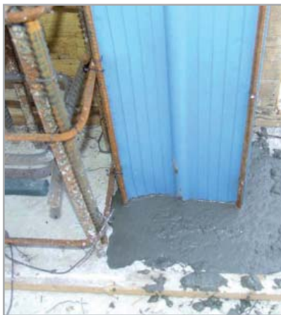
Fig. 7.56e - Ripristino della fondazione con MAPEGROUT COLABILE
