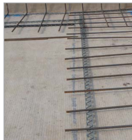
Fig. 7.13 - Armature metalliche posate su MAPEPROOF e separate da esso mediante distanziatori
