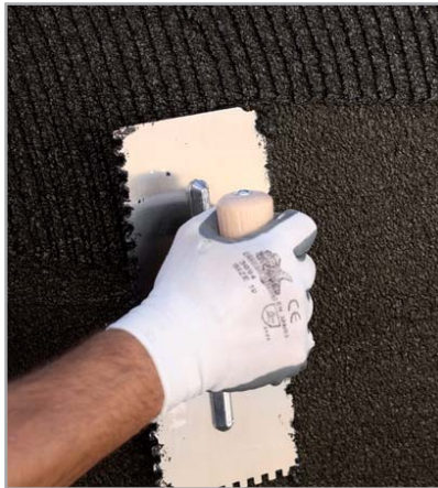
Fig. 7.53 - Applicazione di PLASTIMUL 2K PLUS
