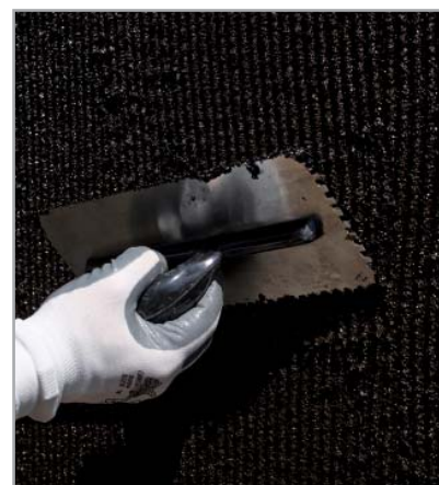
Fig. 7.52 - Applicazione di PLASTIMUL 1K SUPER PLUS
