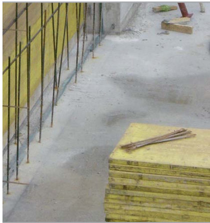
Fig. 7.1 - IDROSTOP B25 messo in opera per sigillare la ripresa di getto orizzontale e verticale
