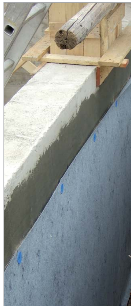
Fig. 7.49 - Protezione dell'impermeabilizzazione nelle fasi di reinterro, mediante la stesura di tessuto non tessuto da 250 g/m 2 a filo continuo
