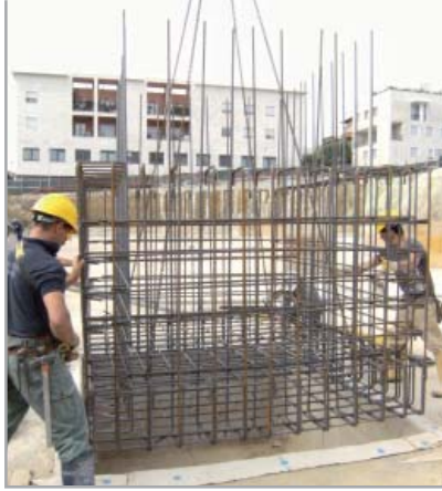
Fig. 7.5c - Posizionamento delle armature
