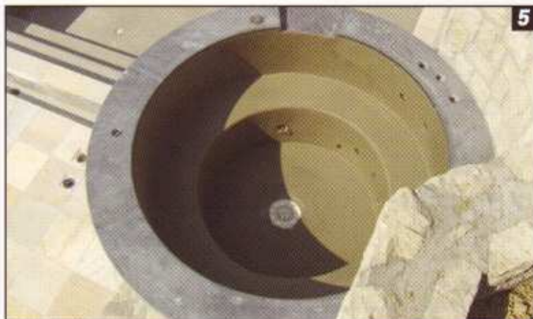
5. Impermeabilización de una bañera de hidromasaje con Mapelastic
