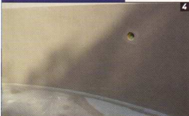
4. Impermeabilización de una piscina con Mapelastic
