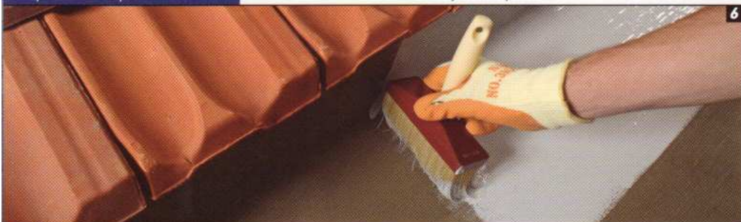
6. Impermeabilización con Mapelastic Smart de un canalón de cemento
