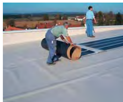
Desenrollado de los Módulos-PV.
