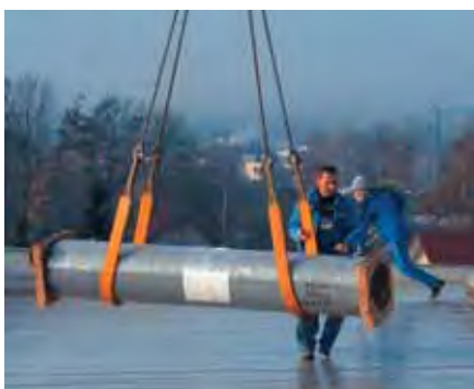
Posicionamiento de los rollos, teniendo en cuenta de la estática puntual del soporte base (estructural) de la cubierta.
