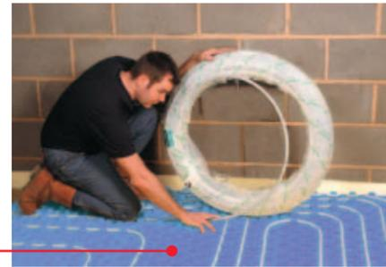
Previo a la colocación de la losa de hormigón se comprobará la estanquidad de los circuitos mediante ensayo a presión igual a dos veces la presión de servicio con un mínimo de 6 bar. Esta presión se mantendrá durante el vertido
