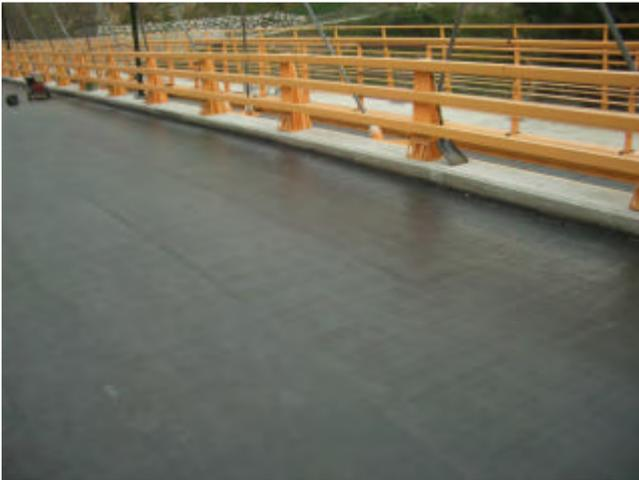
El sistema formado por **MASTERPREN 1001 TP** previa imprimación con **MASTERSEAL 451 (BETTOGUM)** cumple con los requisitos que se detallan a continuación:
