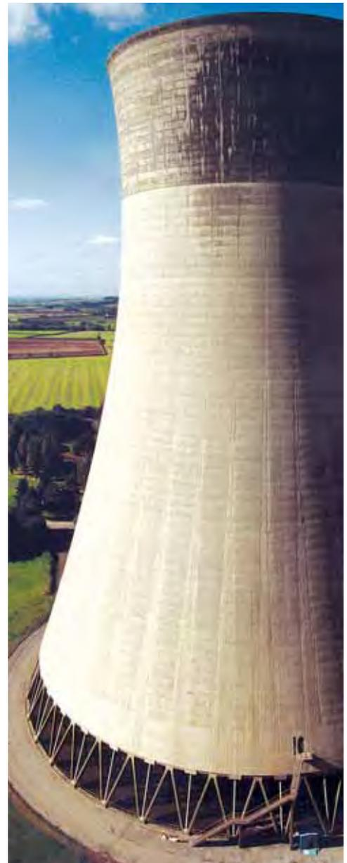
Central eléctrica West Burton UK –reforzada empleando sistemas MBrace® de polímeros armados con fibra de carbono.
