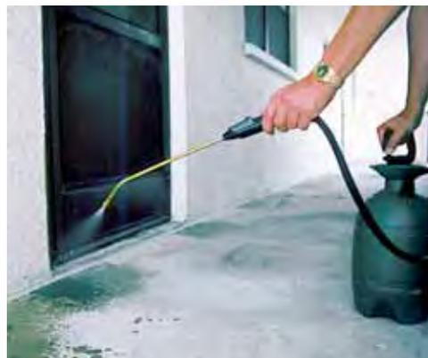
Tras una investigación completa, incluyendo medidas de intensidad de corrosión una reparación por parcheo estándar fue seguida por una aplicación por proyección a baja presión del Protectosil® CIT. Esto redujo extraordinariamente no sólo los elevados niveles de corrosión a un estado pasivo estable sino que evitó la formación de ánodos incipientes en torno a las áreas reparadas.
