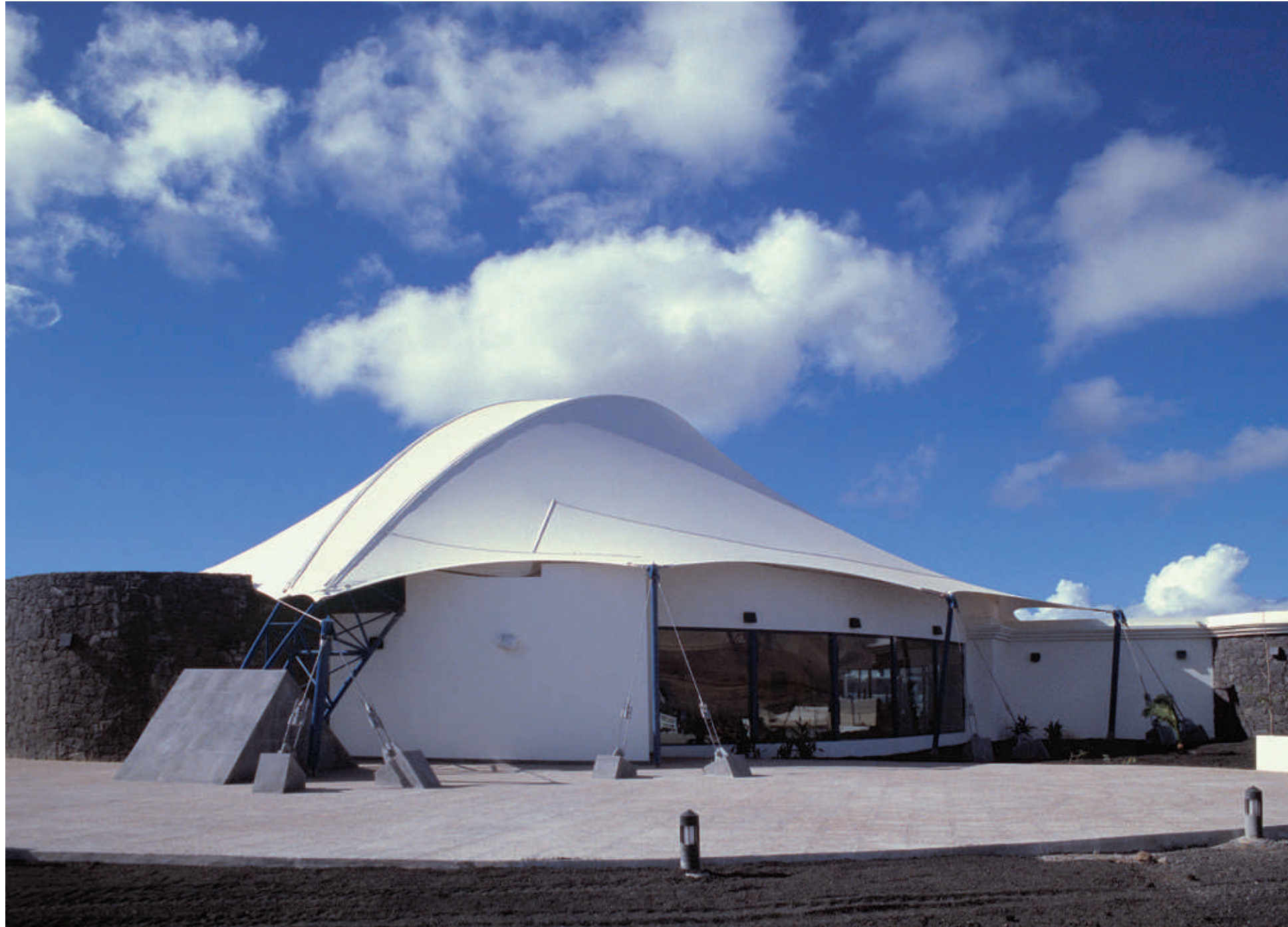
Obra: Sun Tropical Aparthotel Situación: Costa Tegüise, Lanzarote Arquitecto: José Luís Ferreira Superficie: 1.060 m 2 Tejido: Ferrari ref. 1502
