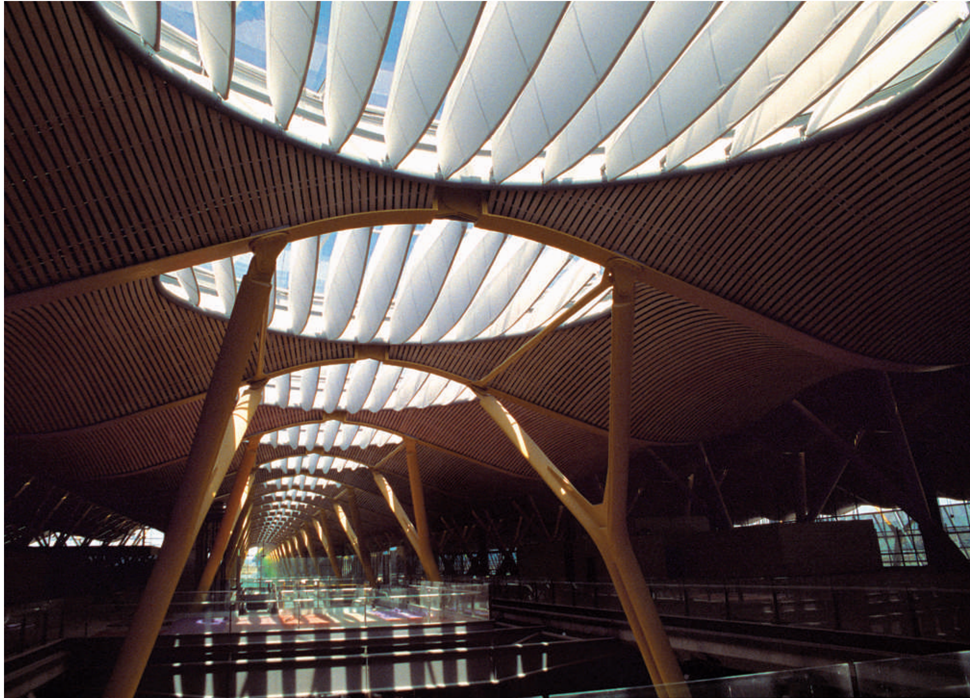
Obra: Terminal T4 Barajas Situación: Aeropuerto Madrid-Barajas Superficie: 75.000 m 2 de tejido Arquitecto: Richard Rogers Partnership/Estudio Lamela Constructora: Ute Terminal/Ute Satellite Tejido: Ferrari ref. Sky 300, lámina transparente de ETFE de 150 µm de espesor
