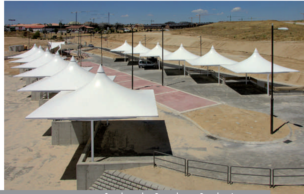
Centro de Residuos Punto Limpio
