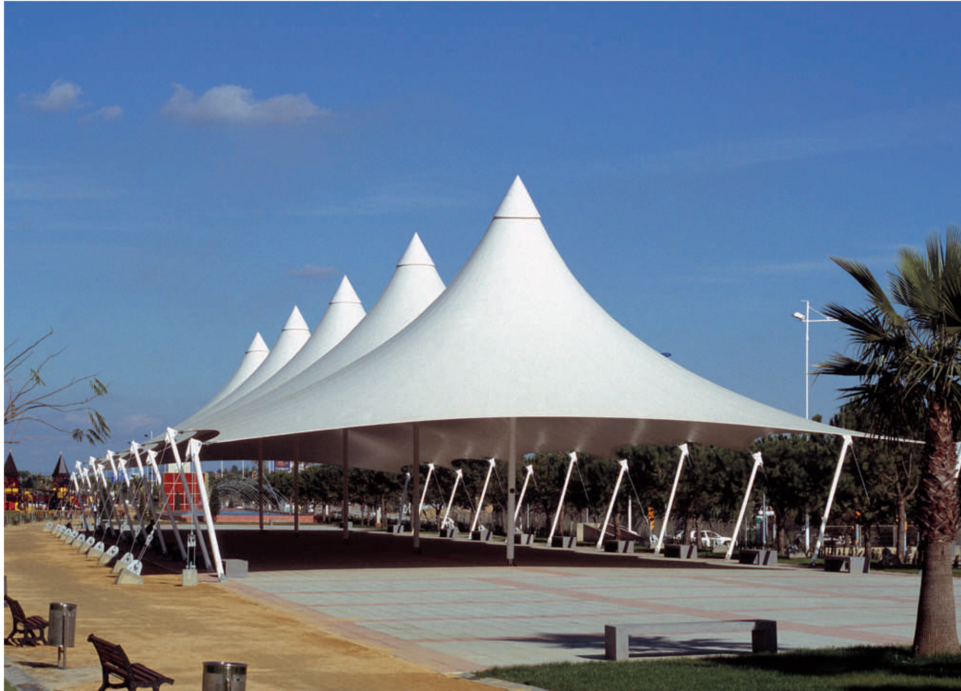
Obra: Urbanización Avda. de Andalucía Situación: Huelva Constructora: RUS construcciones Superficie: 1.900 m 2 Tejido: Ferrari ref. 1002
