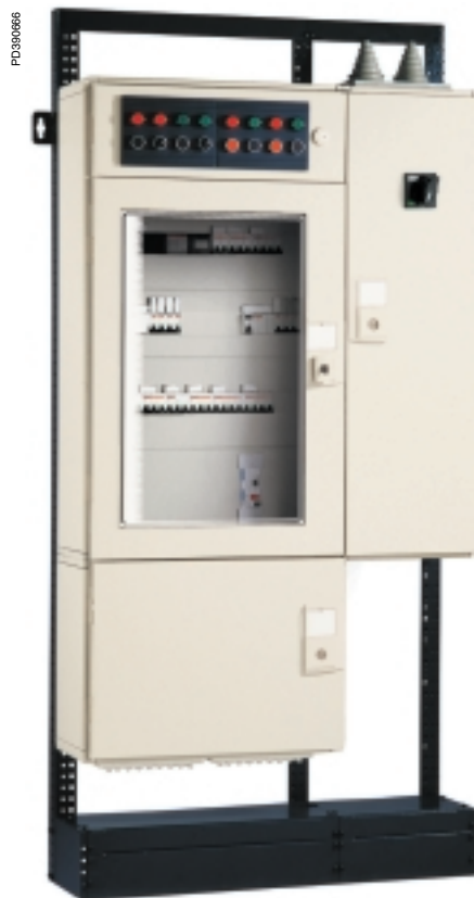
Instalación en estructura mural.
