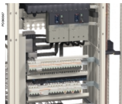
Un Compact NS400 con telemando alimenta filas de aparatos multi 9 mediante un juego de barras aislado Powerclip.
