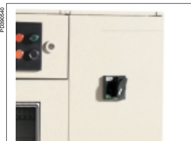
Mando rotativo prolongado en puerta del pasillo lateral.
