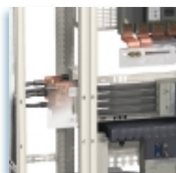
Conexión trasladada al pasillo lateral.
