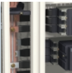
Conexiones prefabricadas del juego de barras Linergy hacia el aparato de salida.
