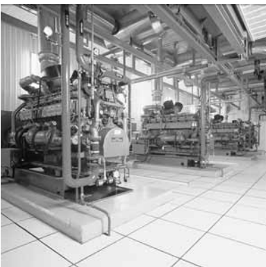
Aplicación de climatización
