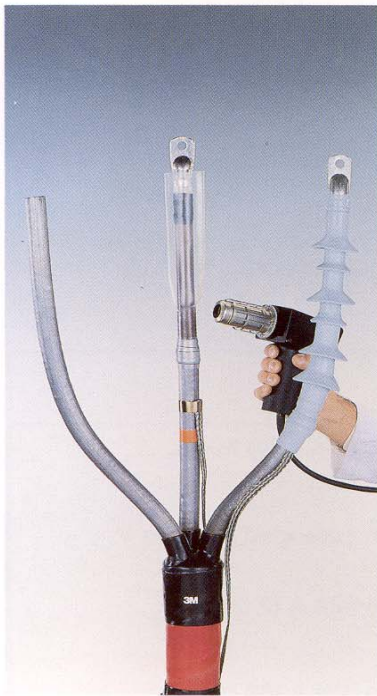
3°. Aplicar tubo termorretractil.
