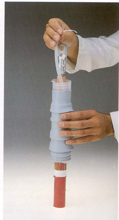
2°. Posicionar el QTII sobre el cable.
