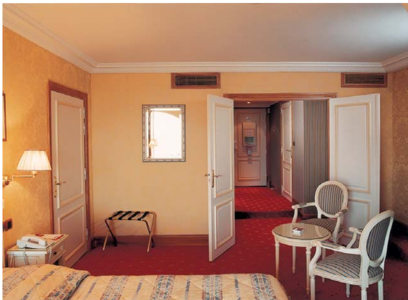
Instalación de rejillas LAC 40 en habitaciones de hotel
