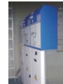
Ejemplo: Esquema OL1L1P de 36 kV dentro del aerogenerador.
